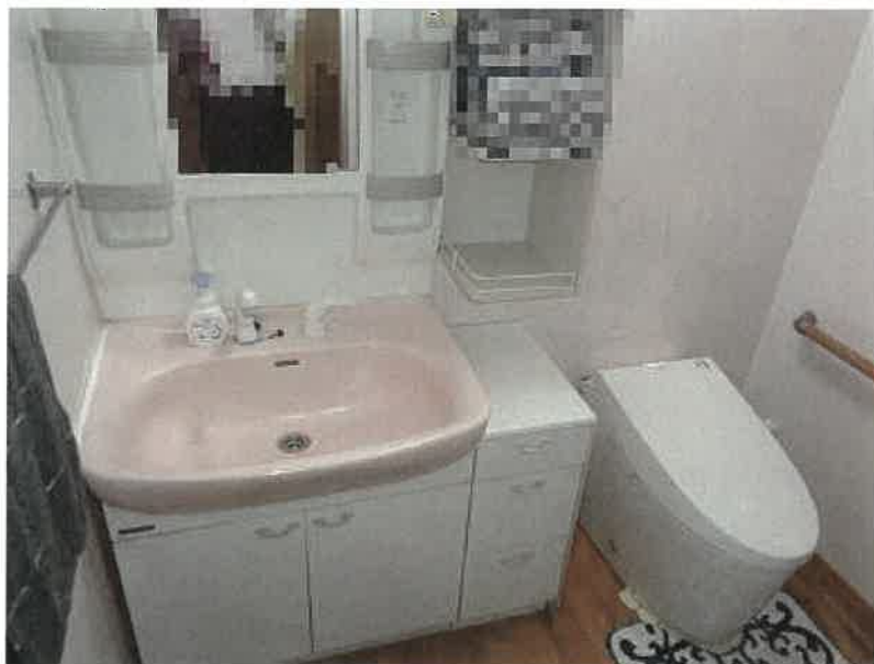
物件4 1階トイレ
