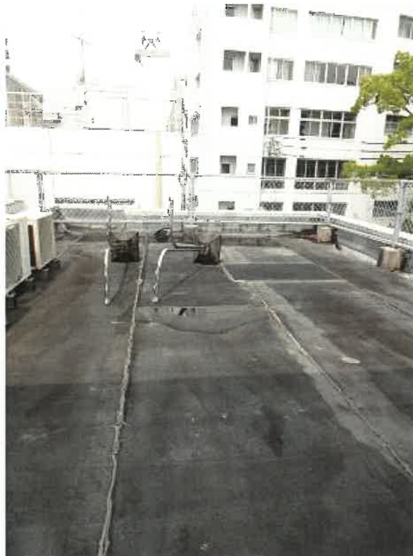
3階部分の屋上
