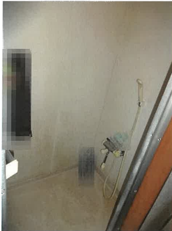
3階シャワー室
