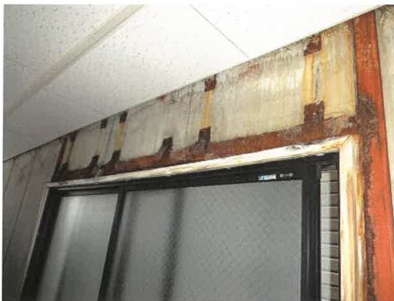
1 階車庫（内壁の状況）
