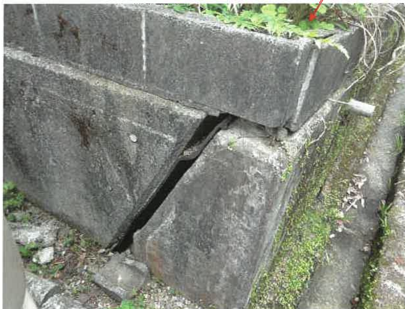
北東側コンクリート擁壁の状況
