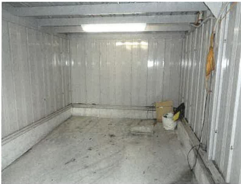
附属建物符号3内部の状況
