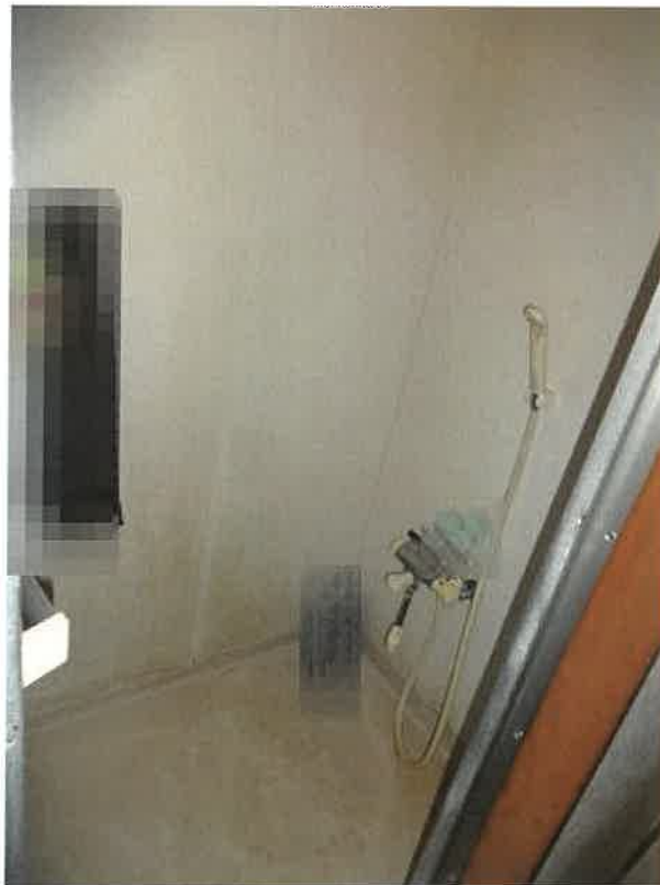
3階シャワー室
