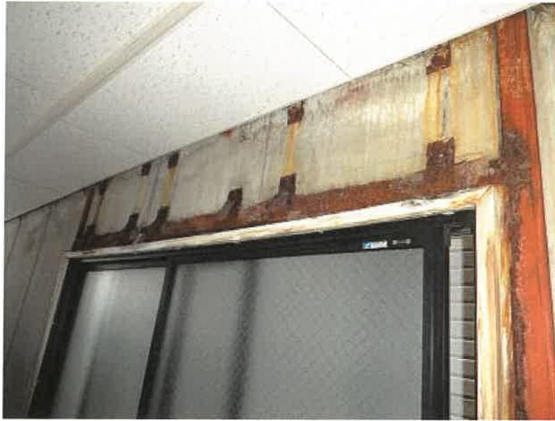
1 階車庫（内壁の状況）
