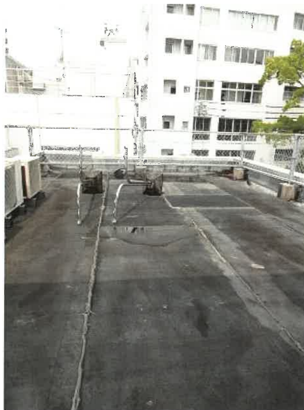
3階部分の屋上
