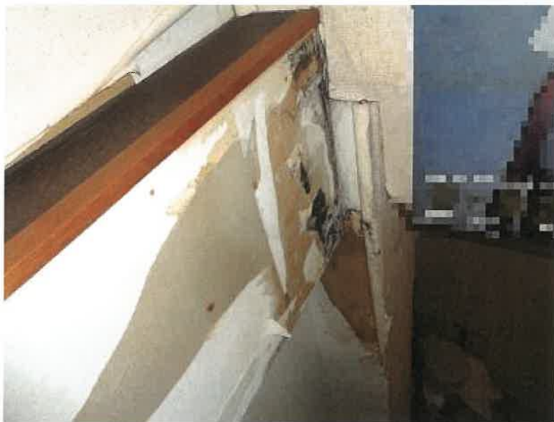
2階から3階への階段の内壁の状況
