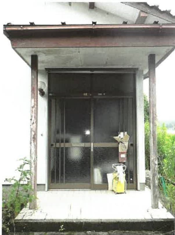
物件3の建物の状況
