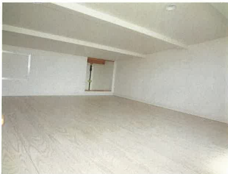
2階洋室(2)上部の屋根裏スペース
