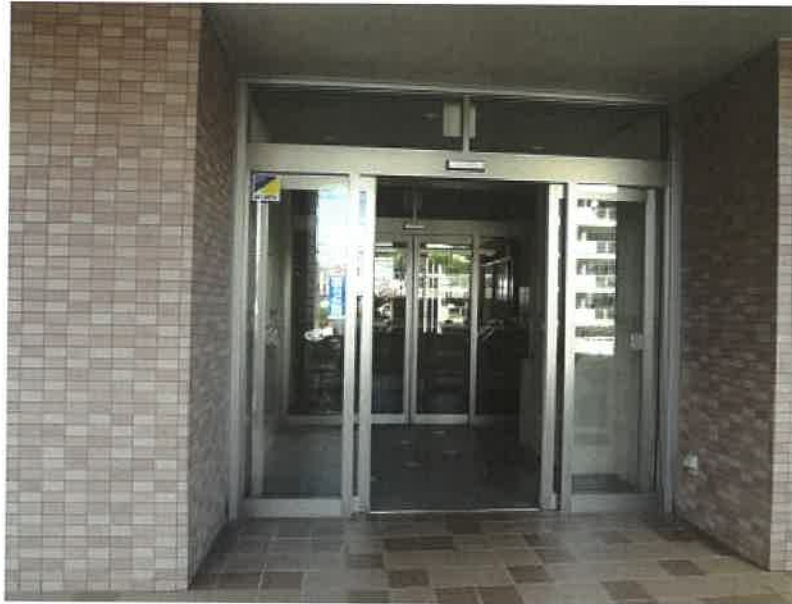
1 階エントランス入口
