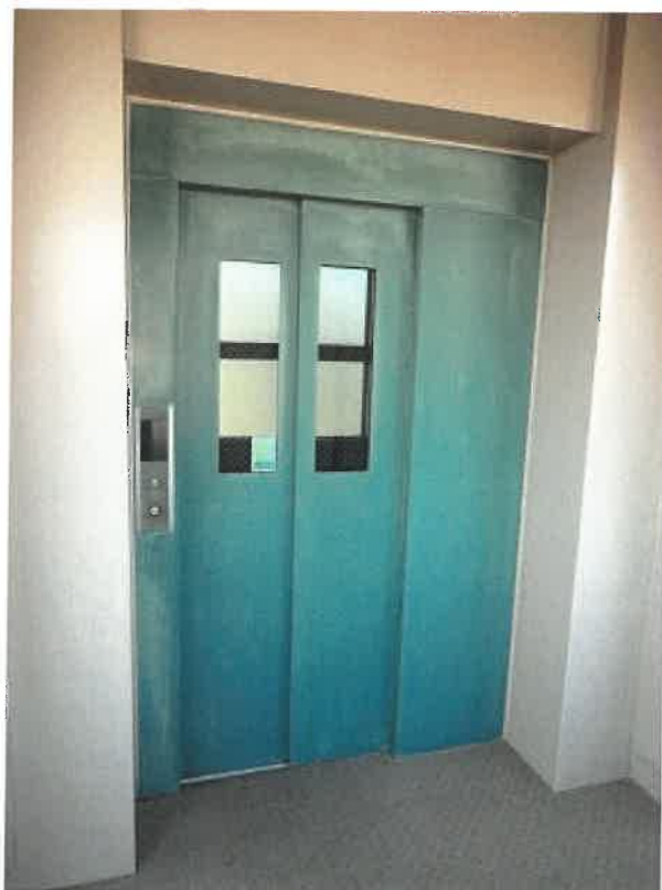
2階エレベーター
