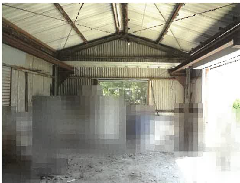
物件4 附属建物符号3内（倉庫）
