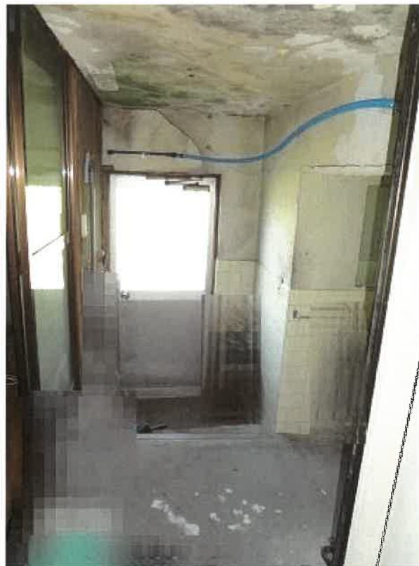
1 階通路（未登記増築部分）
