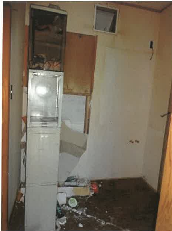
1 階洗面・脱衣場
