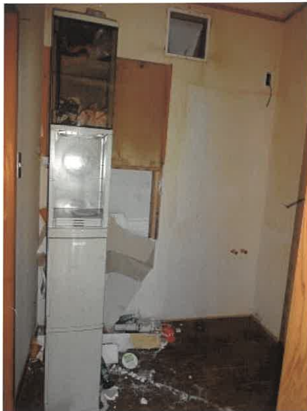
1階洗面・脱衣場
