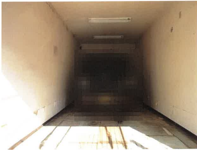
物件3の建物内（車庫）
