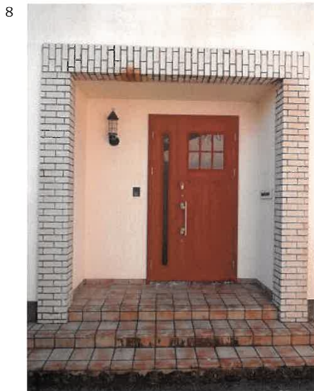
物件 2 の建物（1 階玄関）の状況
