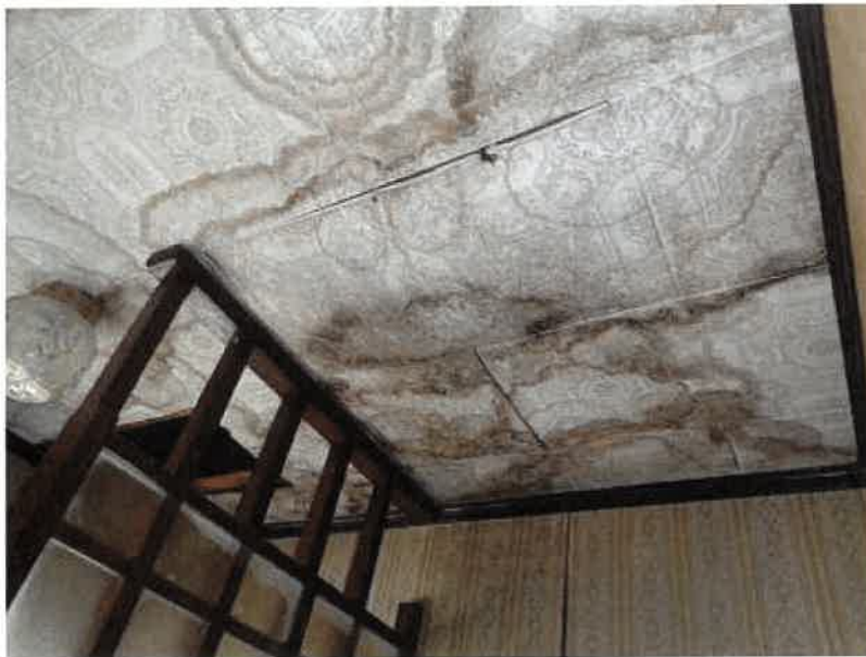
玄関天井の状況
