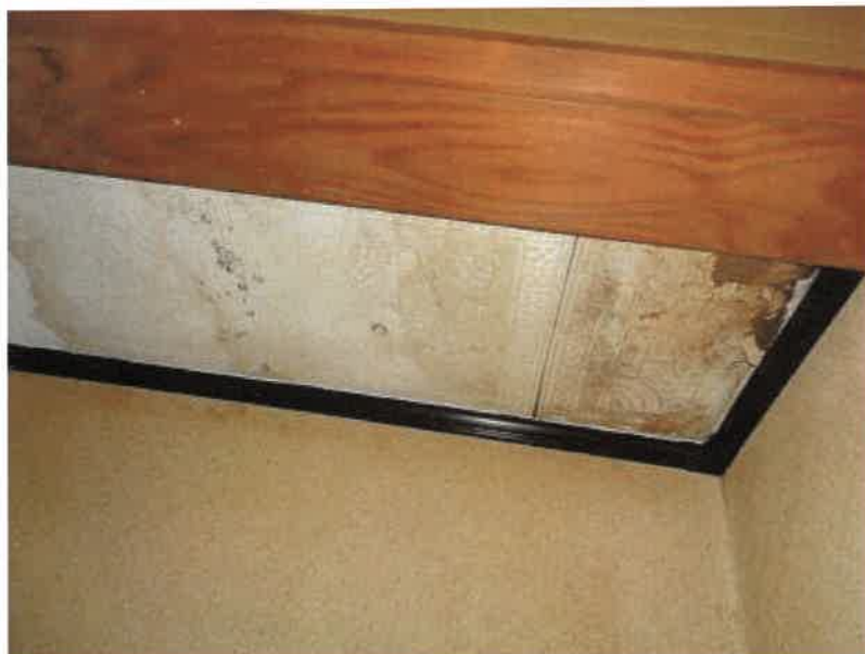
玄関天井の状況
