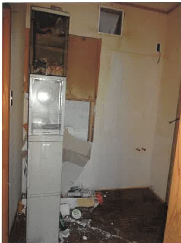
1 階洗面・脱衣場
