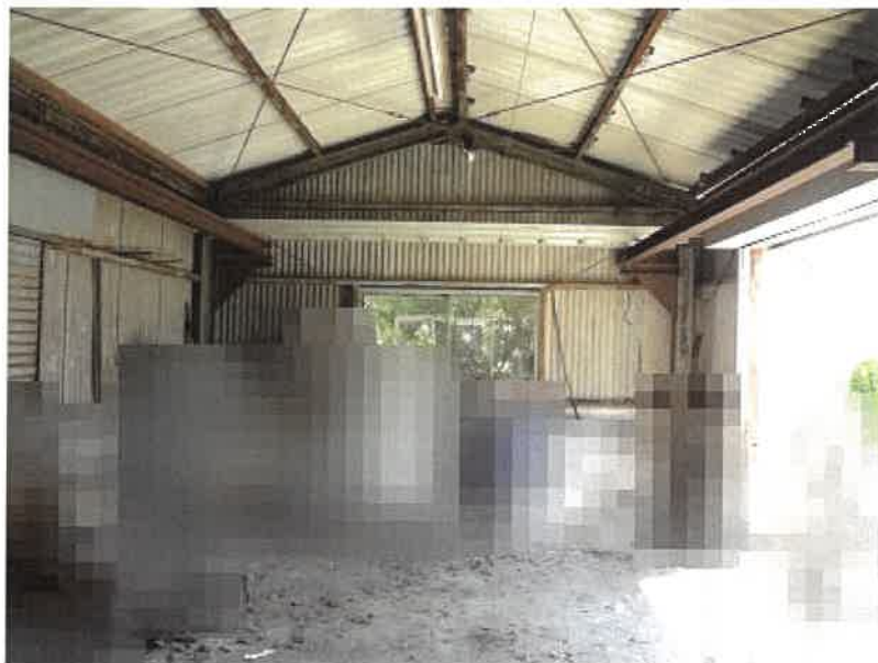
物件4 附属建物符号3内（倉庫）
