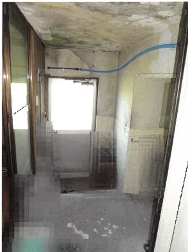
1 階通路（未登記増築部分）
