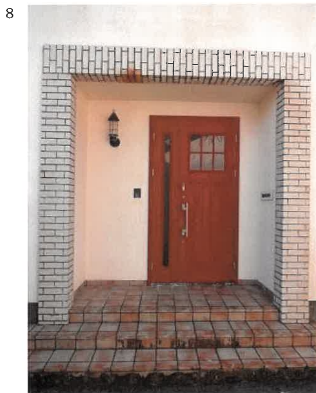
物件 2 の建物（1 階玄関）の状況
