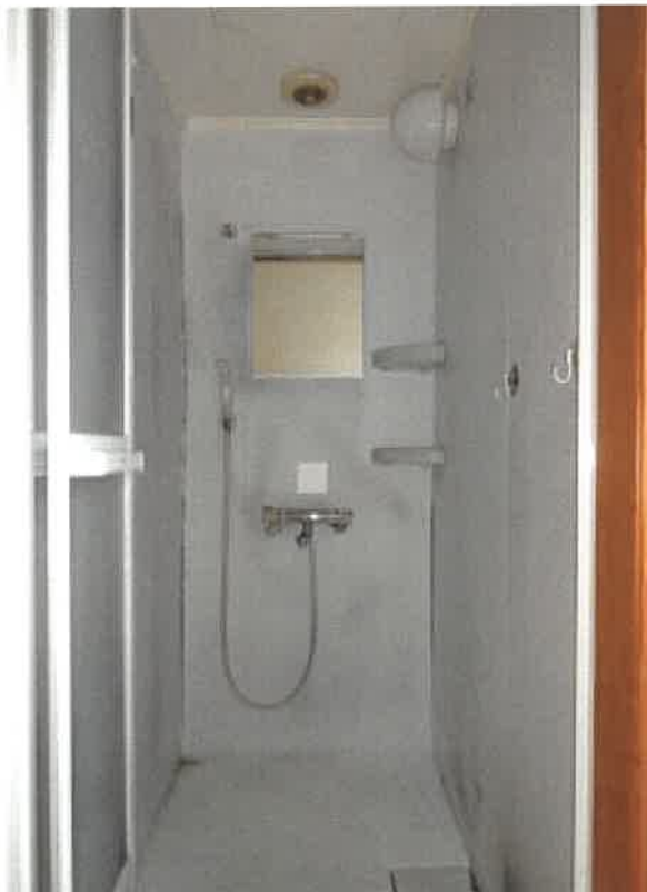
2階シャワー室
