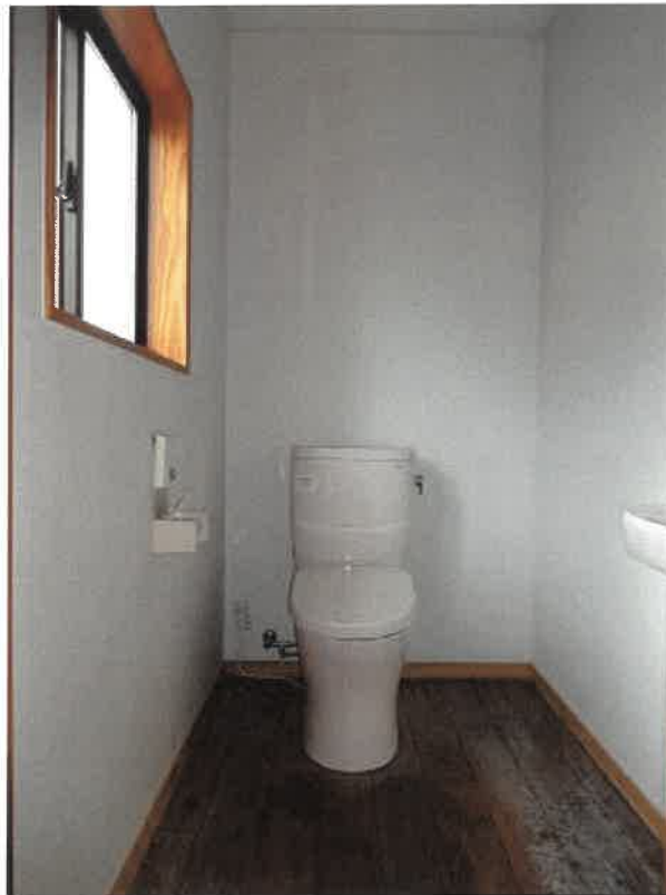
2 階洋室(2)内トイレ(1)
