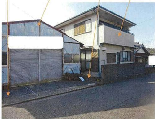
① 地番548番1の土地 物件1 物件2 目的外未登記建物倉庫
