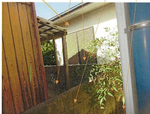
③ 物件2 地番548番2の土地 物件1 西側隣地との境界付近に設置されているブロック塀
