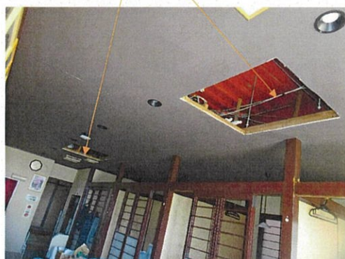
⑪ エアコン撤去跡
