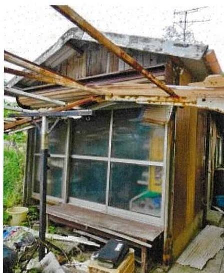
附属建物（未登記）の状況
