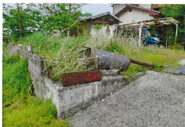
物件1土地の南西付近の状況
