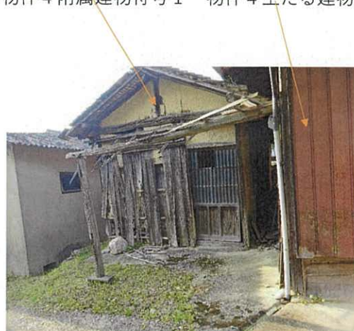
④ 物件4附属建物符号1 物件4主たる建物
