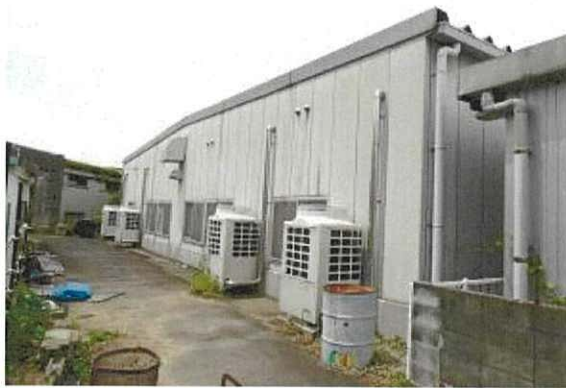
接面道路（東方）の状況
