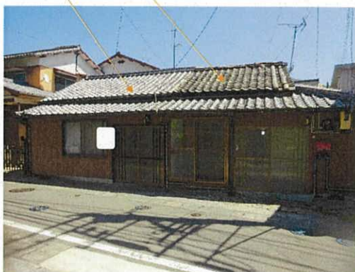
① 物件2 家屋番号伊吹町甲14番1の1の建物
