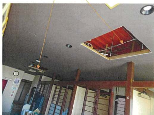
⑪ エアコン撤去跡
