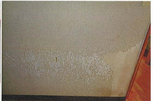
28 (内壁クロスの状況)
