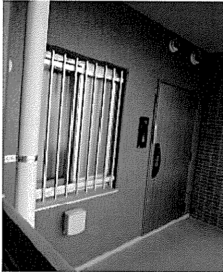
「1705号」の玄関扉付近の状況
