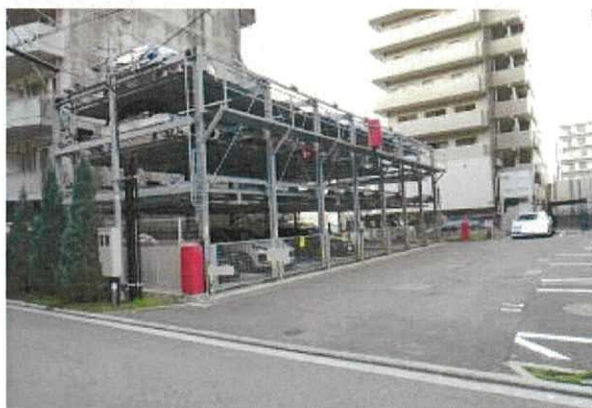
駐車場の状況
