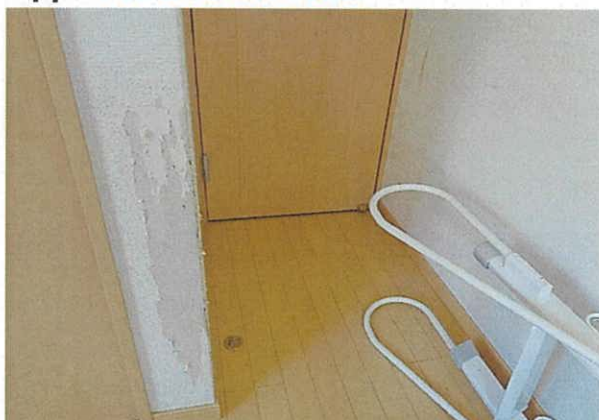
17 (内壁面のクロス状況)
