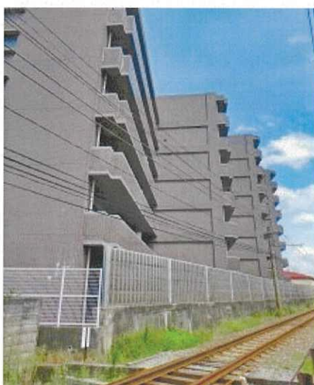
一棟の建物の南側の状況
