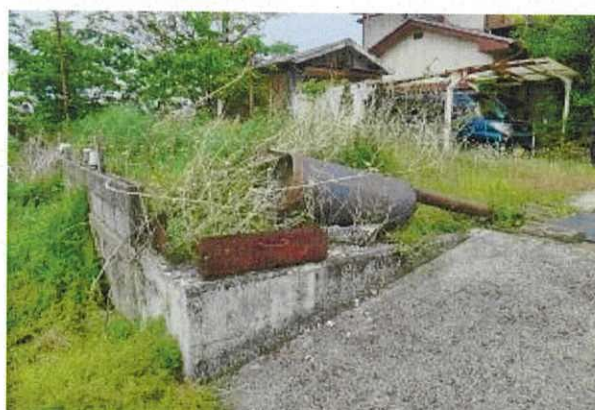
物件1土地の南西付近の状況
