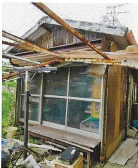
附属建物（未登記）の状況
