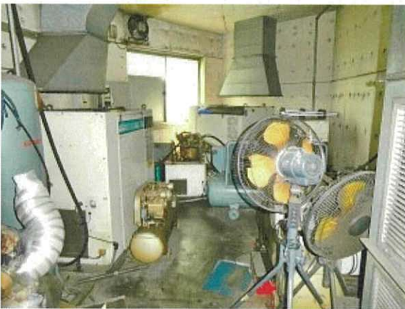
機械室の状況
