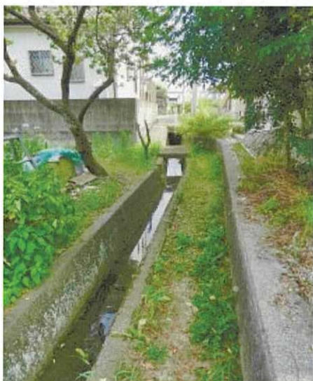
東側未舗装道路の状況
