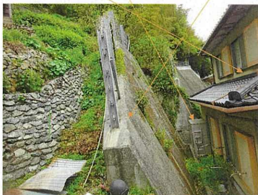
③ 物件1土地内に設置されているコンクリート擁壁 物件2 動産物置
