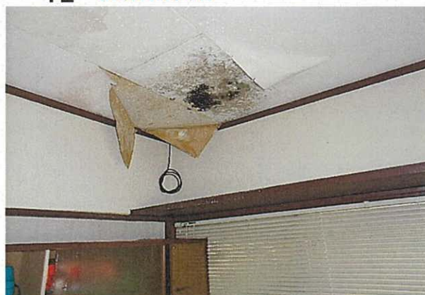
12 (天井材の状況)
