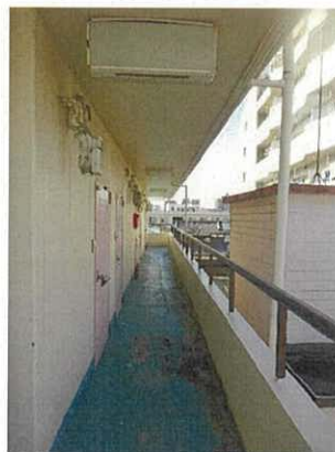
⑥ 2階共用通路
