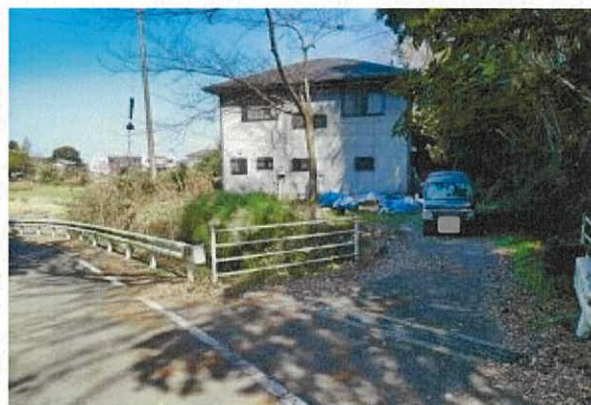
床版の設置状況
