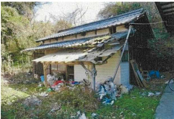
以下、物件2建物の状況
