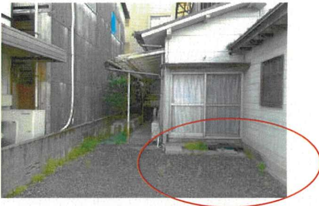
コンクリート布基礎の損傷状況
