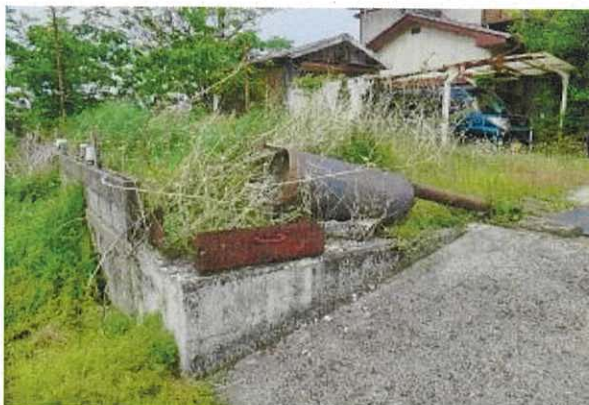
物件1土地の南西付近の状況
