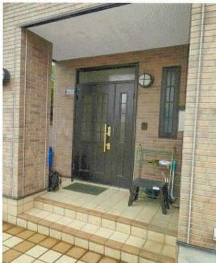
玄関外側部分の状況
