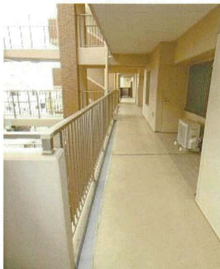
開放廊下の状況
