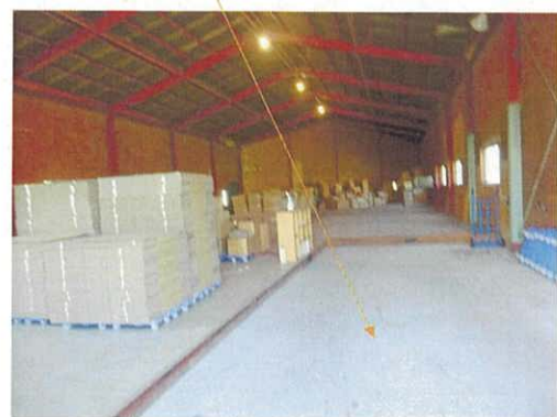
⑥ 物件5 内部 土間コンクリート
