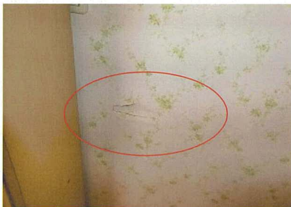
壁の陥没の状況
