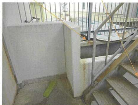
5階から6階への外階段 隣地上の建物
