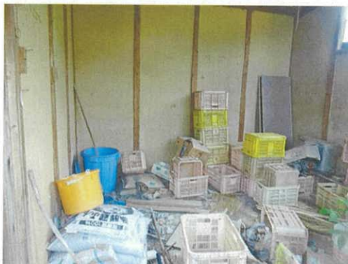
④7 物件 4 附属建物符号 2 内部
