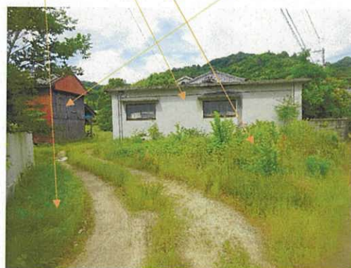
物件 4 主たる建物未登記増築部分 物件 5 物件 3 物件 4 附属建物符号 1
