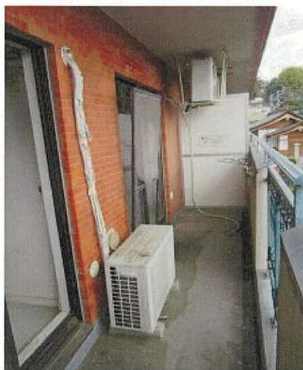
バルコニーの状況
