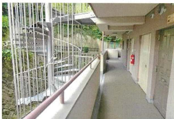
開放廊下の状況
