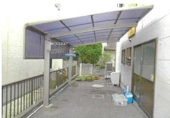
カーポートの状況
