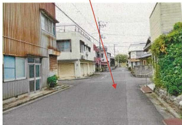
市道 接面道路（南西側）の状況
