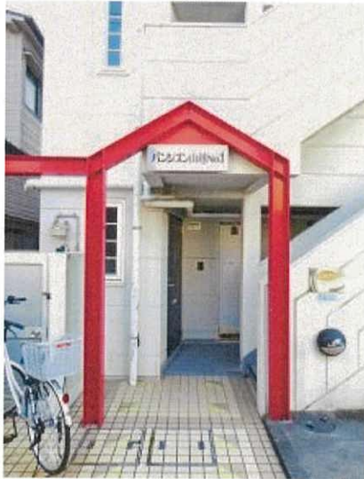
エントランス部分の状況
