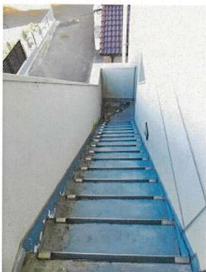
2階から3階への階段の状況
